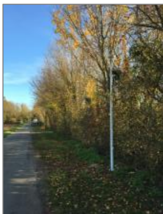
Rue des Champs Rénovation de l'éclairage public
