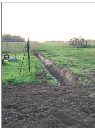
Rue du Gros Chêne Travaux eaux pluviales
