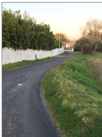
Rue du Rocher Travaux de voirie
